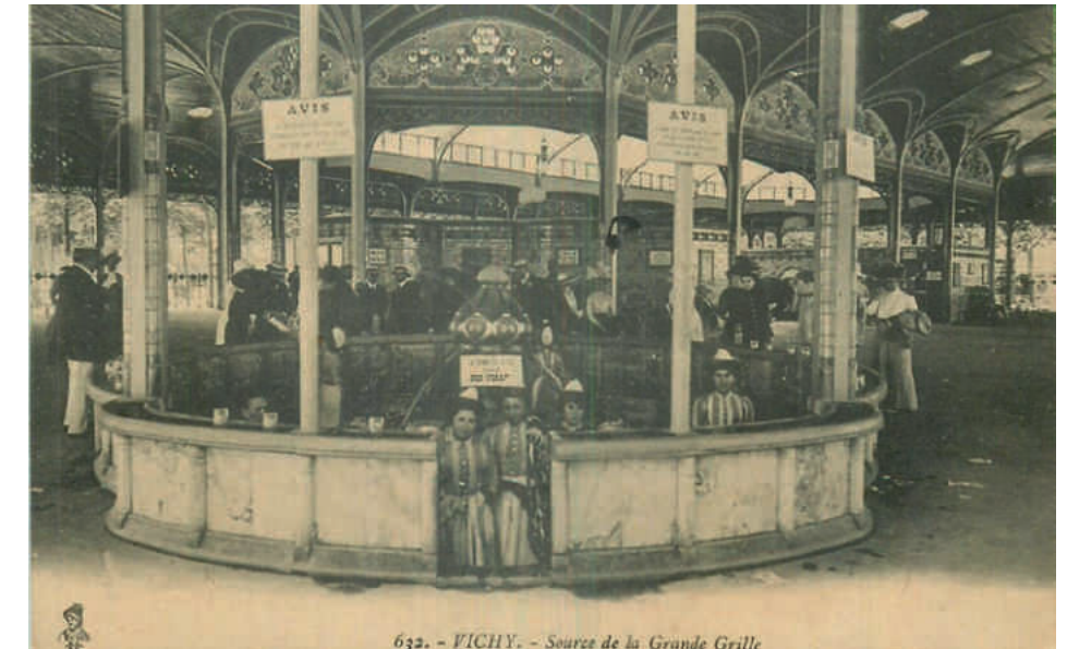
Halle des sources, mur bahut intégrant les poteaux métalliques
