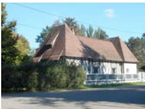
Cottage - ancienne route de Gannat
