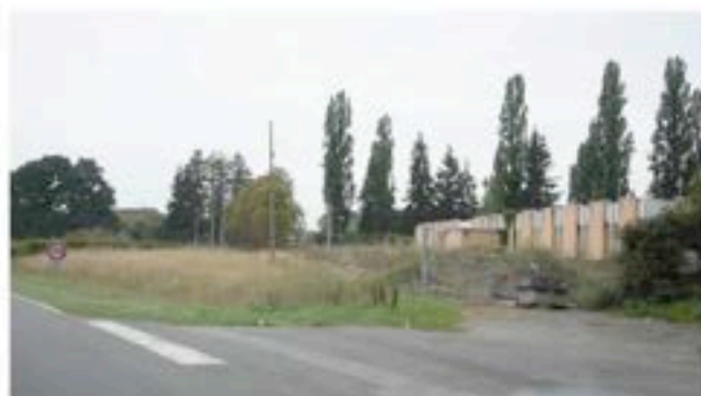
Structure désaffectée en entrée de ville
