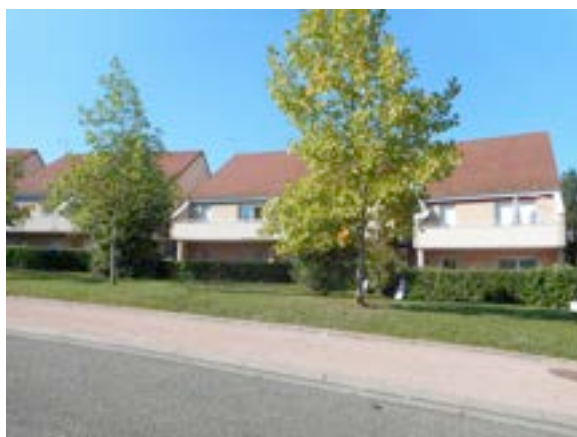
Logements collectifs – rue Emmanuel Chabrier
